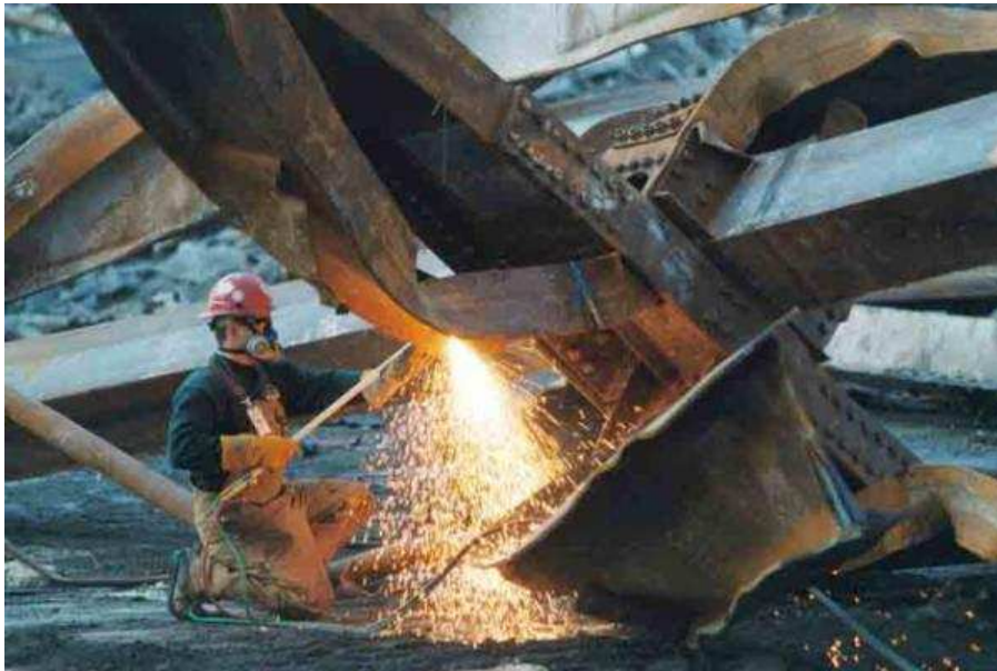
Trennarbeiten beim Aufräumen. Die Verbindungsnieten haben gehalten.
