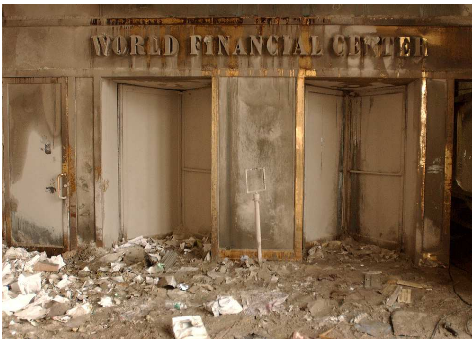
Rostfahnen am WTC-Eingang
