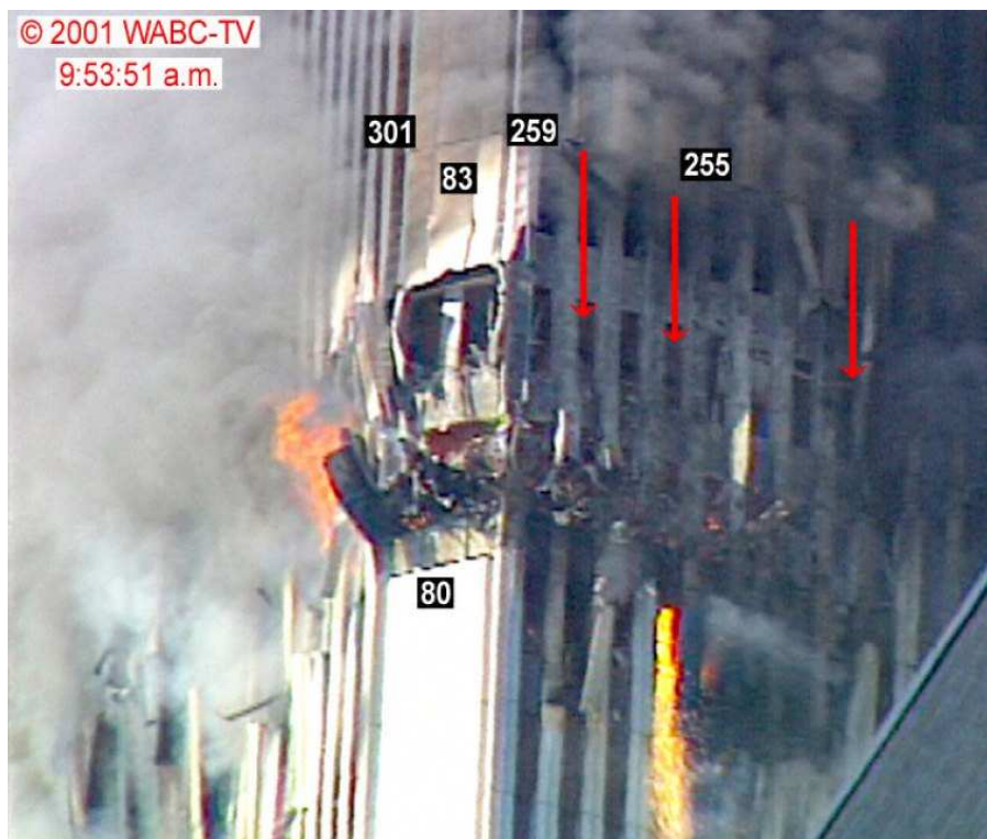
geschmolzener, orange-glühender Stahl tropft aus dem Südturm, kurz vor dessen Zusammenbruch
