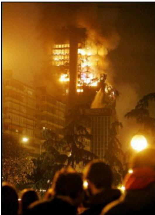
Madrid, Windsor Tower. So sieht es echtes Inferno aus. Teile der Stahlkonstruktion stürzten ein. Aber der Brand dauerte über 24 Stunden und erstreckte sich über ein Dutzend Stockwerke.
